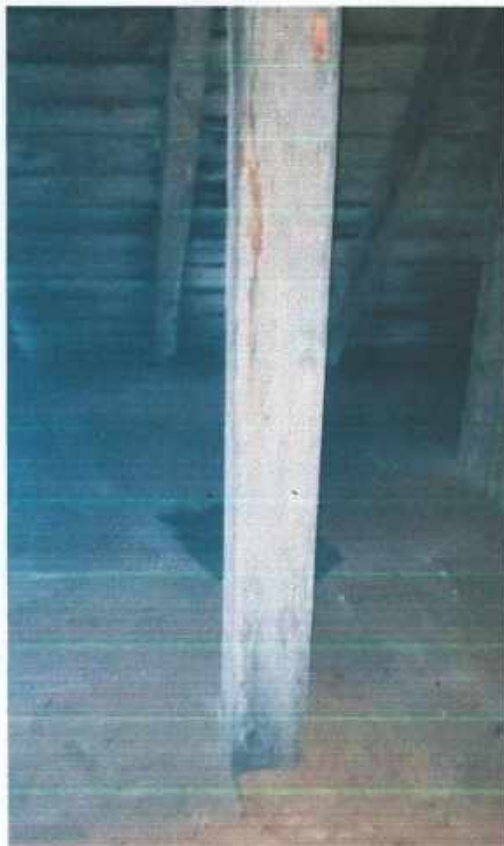
Фото №13 – вид чердачного перекрытия со стороны чердачного пространства (обследование конструкций фото от 07.10.2021г.)
