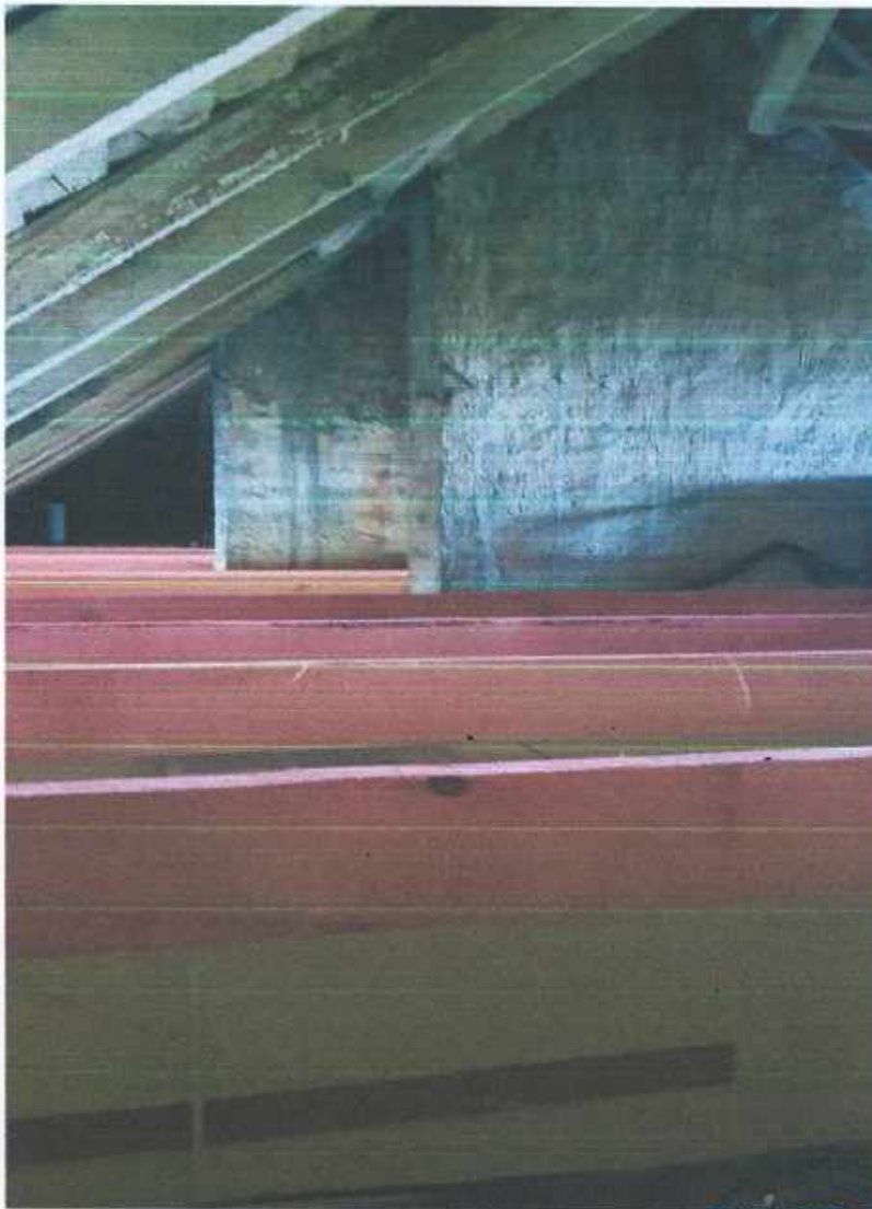
Фото №4 – балки чердачного перекрытия (на момент проведения капитального ремонта)
