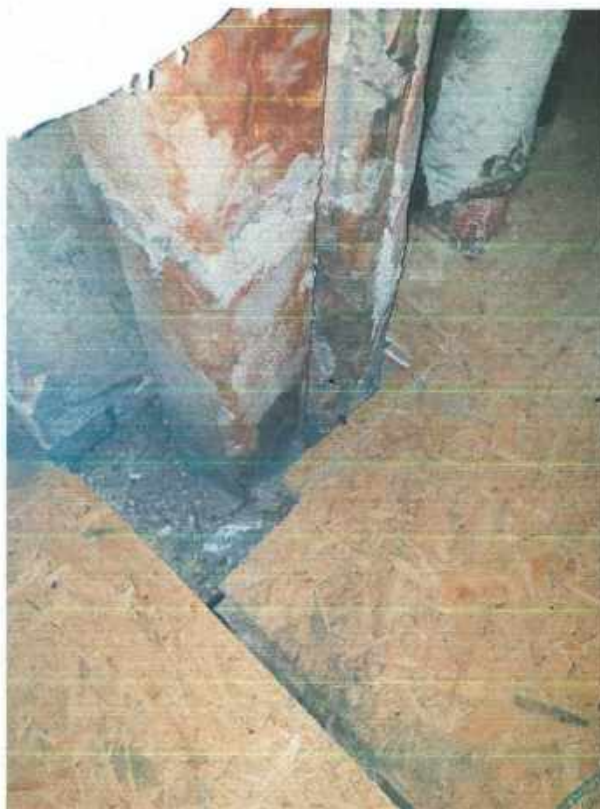
Фото №16 – вид чердачного перекрытия со стороны чердачного пространства (место прокладки коммуникаций через перекрытие) - (обследование конструкций фото от 07.10.2021г.)
