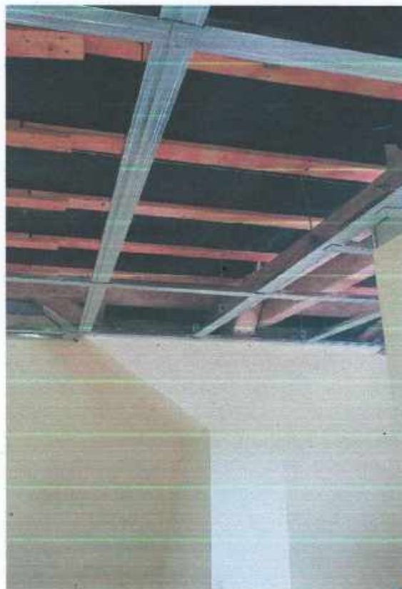
Фото №8 – вид чердачного перекрытия со стороны мансардного этажа (на момент проведения капитального ремонта)
