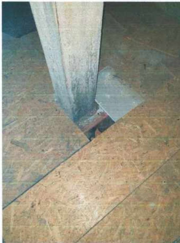
Фото №20 – место вскрытия перекрытия (вид до разбора конструкций) (обследование конструкций фото от 07.10.2021г.)
