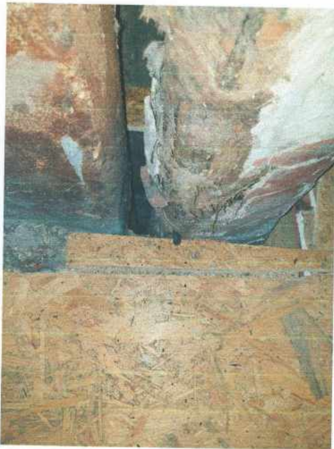
Фото №17 – вид чердачного перекрытия со стороны чердачного пространства (место прокладки коммуникаций через перекрытие) - (обследование конструкций фото от 07.10.2021г.)
