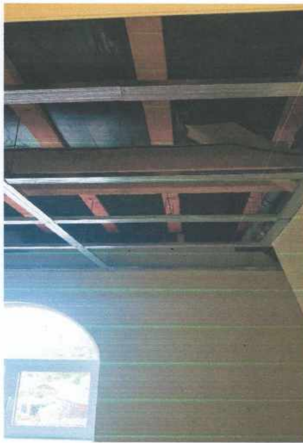
Фото №7 – вид чердачного перекрытия со стороны мансардного этажа (на момент проведения капитального ремонта)
