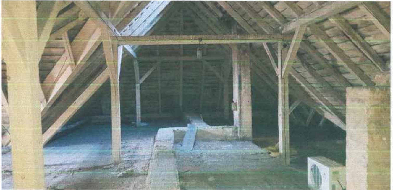
Фото №1 – чердачное перекрытие до капитального ремонта
