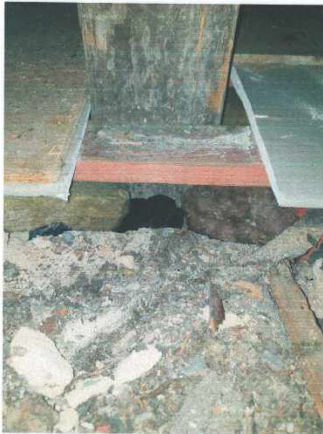
Фото № 22 – место вскрытия перекрытия (обследование конструкций фото от 07.10.2021г.)
