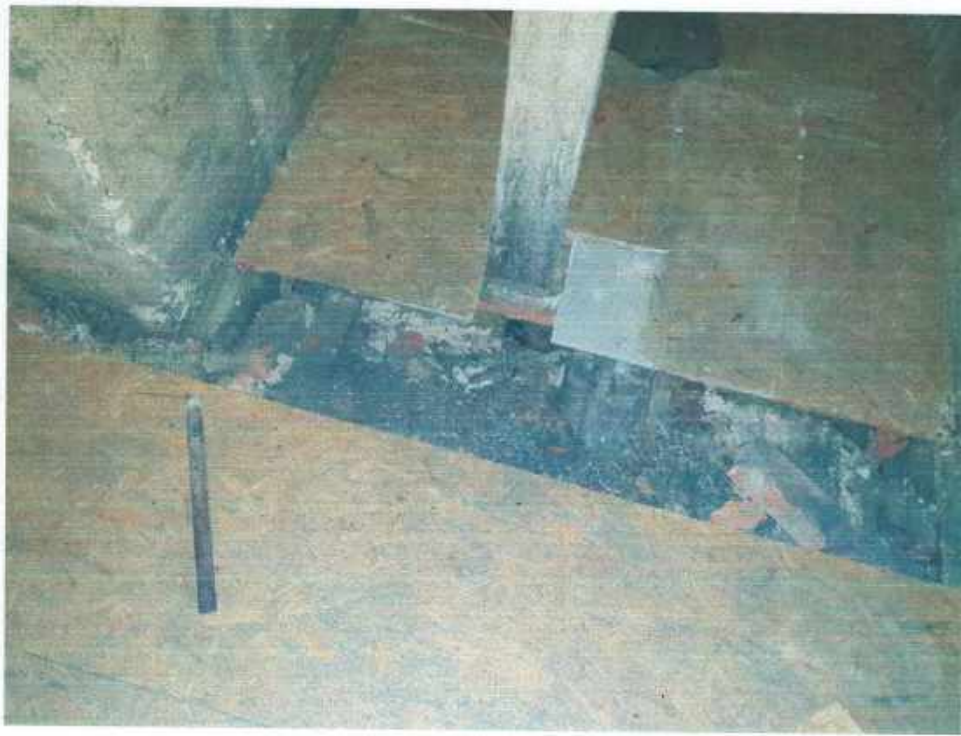
Фото № 21 – место вскрытия перекрытия (обследование конструкций фото от 07.10.2021г.)
