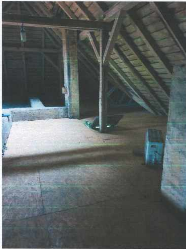
Фото №11 – вид чердачного перекрытия со стороны чердачного пространства (обследование конструкций фото от 07.10.2021г.)
