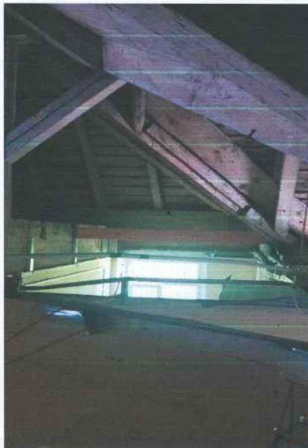
Фото №6 – вид чердачного перекрытия (на момент проведения капитального ремонта)
