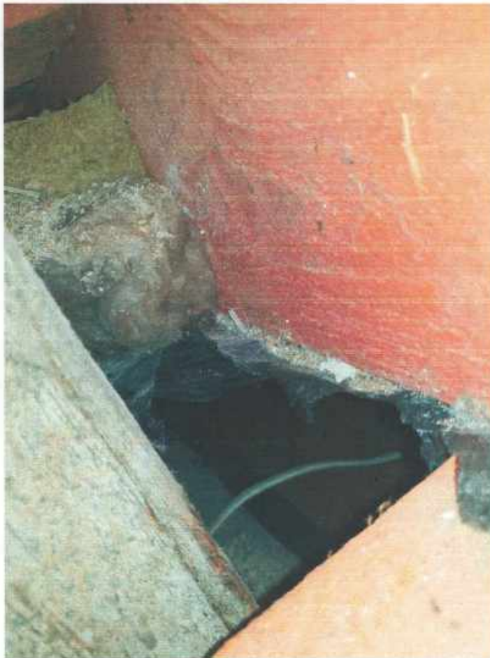
Фото № 23 – место вскрытия перекрытия (пространство между балками и под балками) (обследование конструкций фото от 07.10.2021г.)
